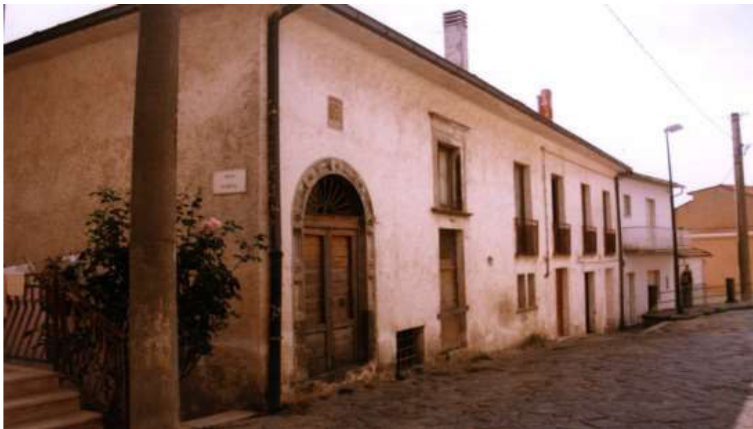
Corso Umberto I, Palazzo Santosuosso prima della ristrutturazione
